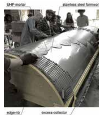
1 Starten van een cilindervormige schaalconstructie met textiel gewapend beton
