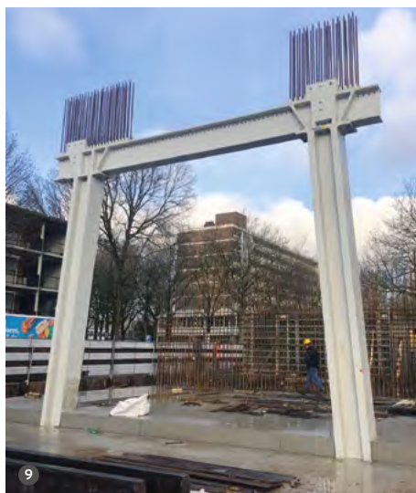
8 Doorsnede gevels Quartz 9 Stalen walking columns vormen een A-portaal 10 Overzicht A-portaal
