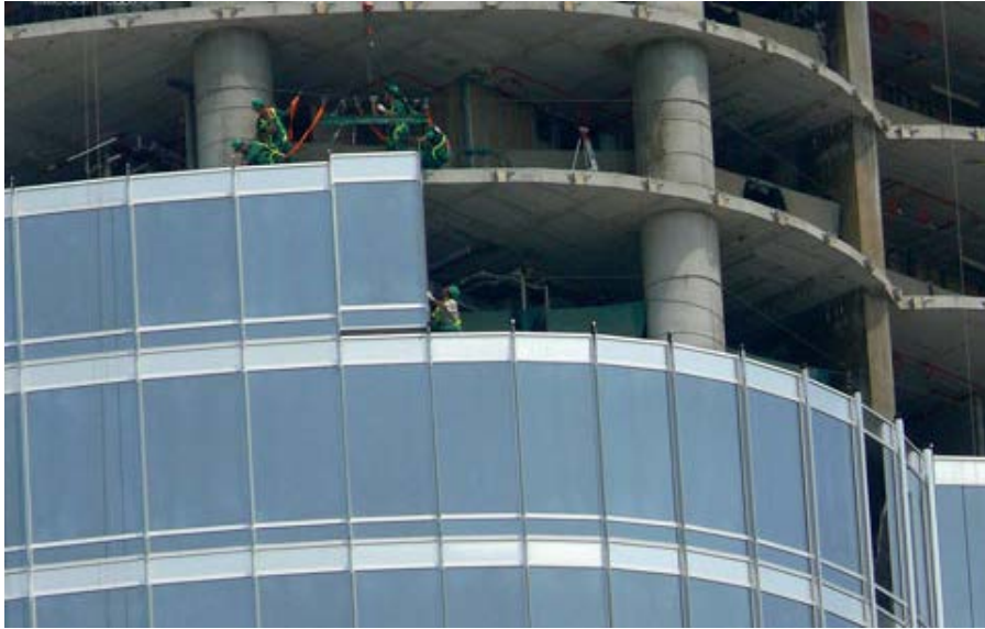
Afbeelding 6 - Plaatsen gevelsysteem Burj Khalifa [6]
