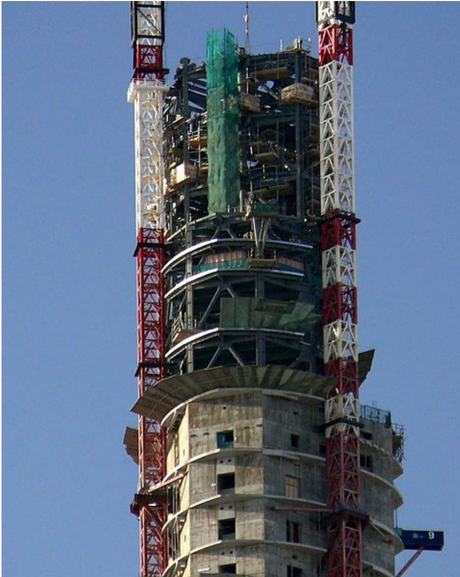
Afbeelding 1 - Overgang beton-staal Burj Khalifa [1]
