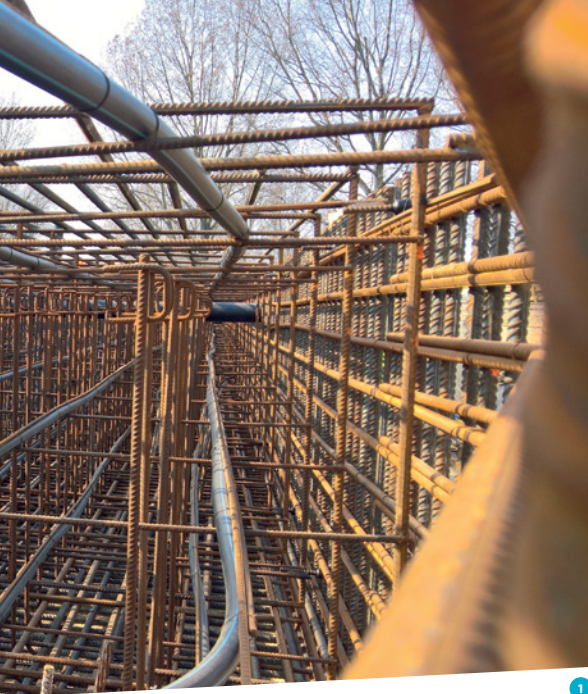
1 Koelbuizen in de constructie van viaduct Bleizo
