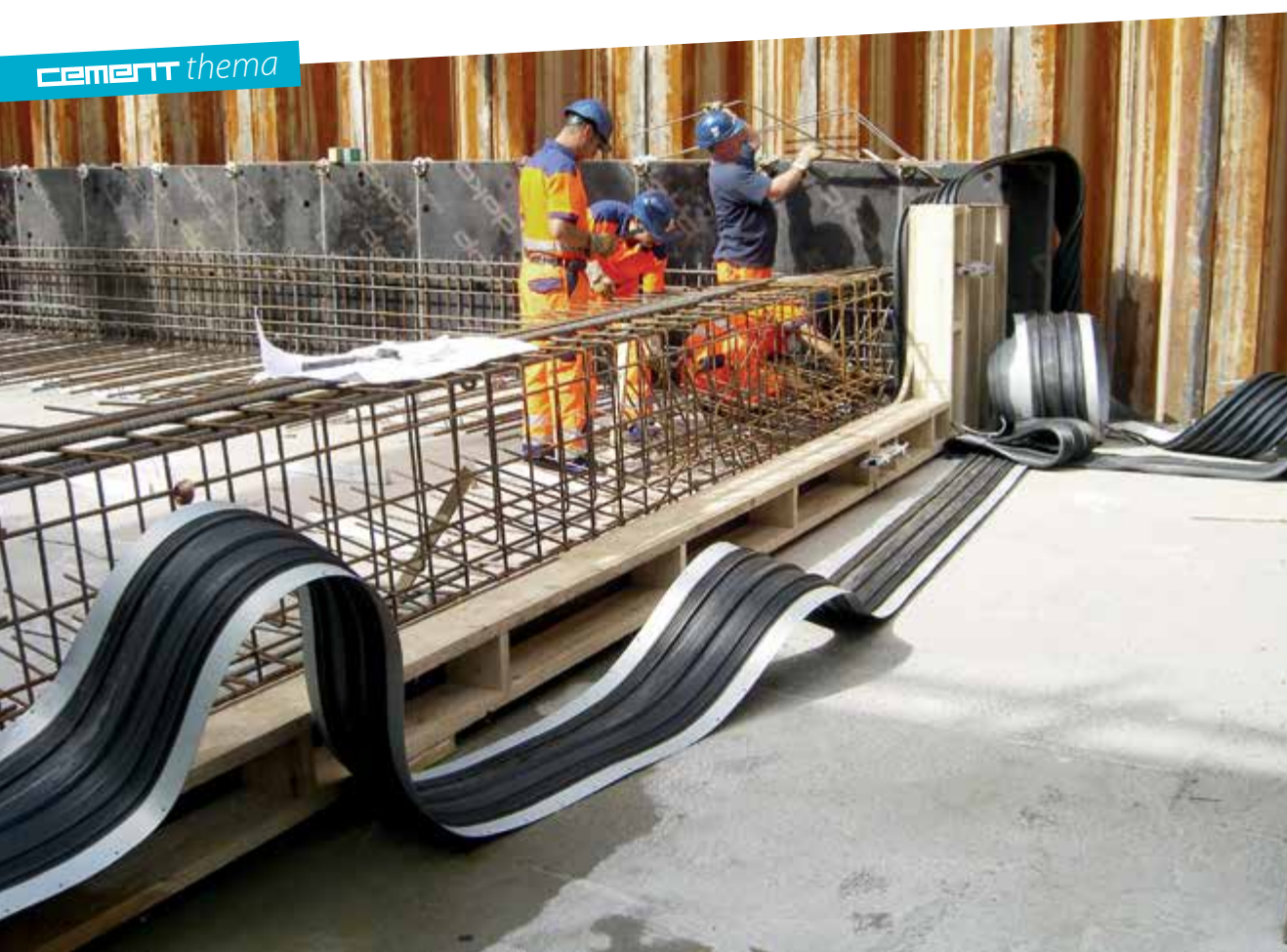
8 Het aanbrengen van voegband als afdichting kan vervormingen en scheuren, en daarmee lekkage voorkomen
