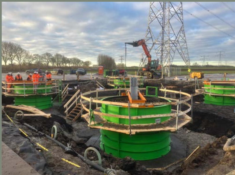
3 Mastfundatie TenneT, Platzers eerste project waarin hij het ontwerpproces volledig digitaliseerde en automatiseerde
