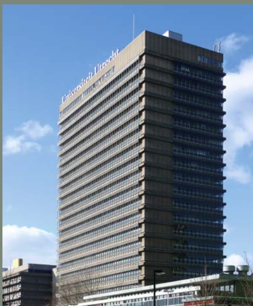
Foto 1 Na onderzoek van het Willem C. van Unnikgebouw op het Utrecht Science Park bleek de hoofd-draagconstructie in goede conditie voor hergebruik. Foto: Wikimedia
