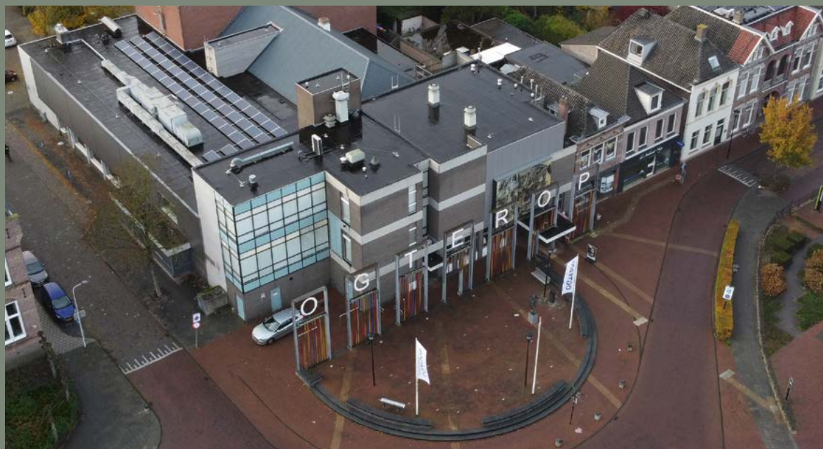
Foto 4 Bij de vernieuwbouw van schouwburg Ogterop in Meppel wordt gekeken welke bouwdelen kunnen worden behouden en welk materiaal kan worden hergebruikt in de nieuwbouw. Foto: Wikimedia
