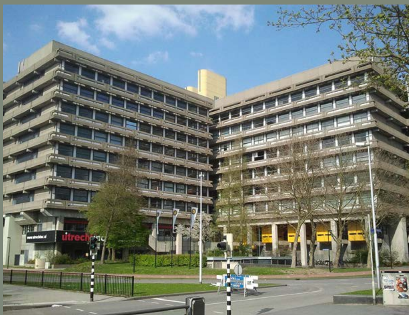
Foto 2 Ook het robuuste betoncasco van het Hugo R. Kruytgebouw van de Universiteit Utrecht is nog in prima staat en geschikt voor herontwikkeling. Foto: Wikimedia
